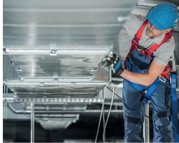
o lana di vetro contenenti FAV potenzialmente cancerogene. Con il passare del tempo le coibentazioni si deteriorano creando il rischio potenziale di rilascio di fibre negli ambienti. L'intervento definito "Coating" viene realizzato nebulizzando uno specifico prodotto antifungino, antibatterico e certificato, che incapsula e sigilla i materiali evitandone la dispersione all'interno delle condotte e degli ambienti.
